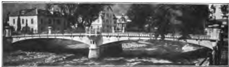
Abb. 79. Passerbrücke in Meran.
